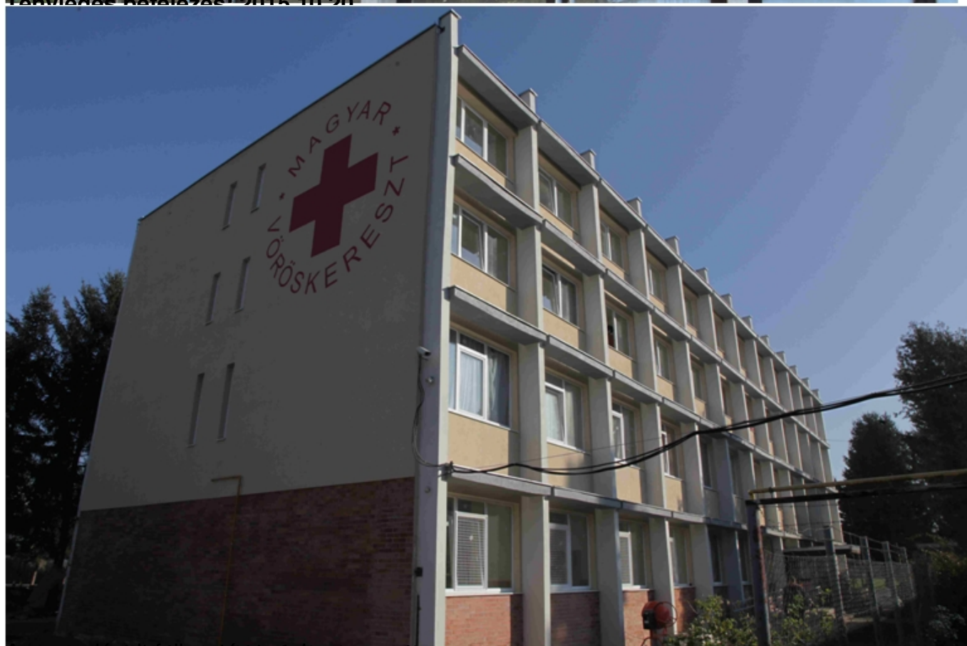
A tégelyes falazat hőszigetelésének kiváltása, új falazóelem konstrukciója, kialakítása A hőszigetelés kiváltása, új falazóelem konstrukciója, kialakítása, a hőszigetelés kiváltása, új falazóelem konstrukciója, kialakítása
